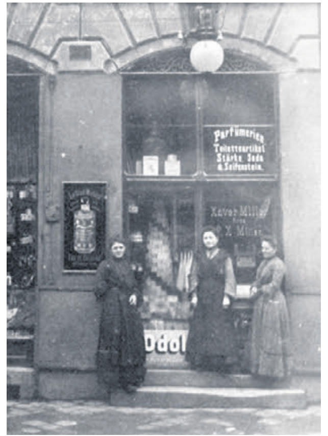
Das Geschäftshaus am Neupfarrplatz um 1900
